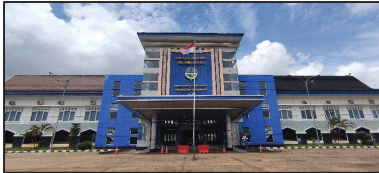
Gambar 1.1 Terminal Tipe A Sei Ambawang BPTD Kelas II Kalimantan Barat
