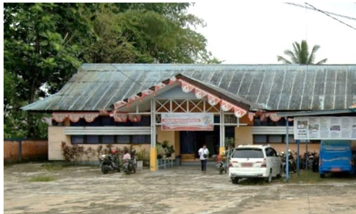
Gambar 1.3 Bangunan Kantor Perpustakaan Daerah Kab. Sintang
