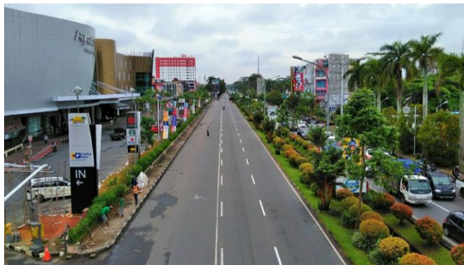
Gambar 1.1 Pembangunan Jalur Pedestrian di Jalan Jenderal Ahmad Yani Sumber: Penulis, 2024
