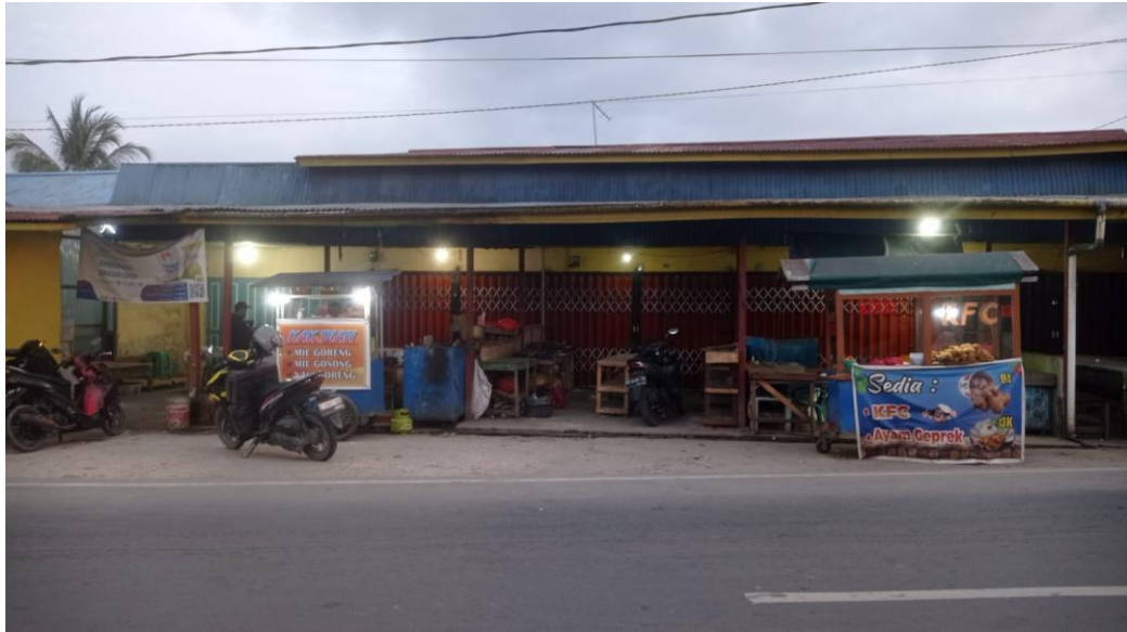
Gambar 1.2 Kondisi pasar saat sore
