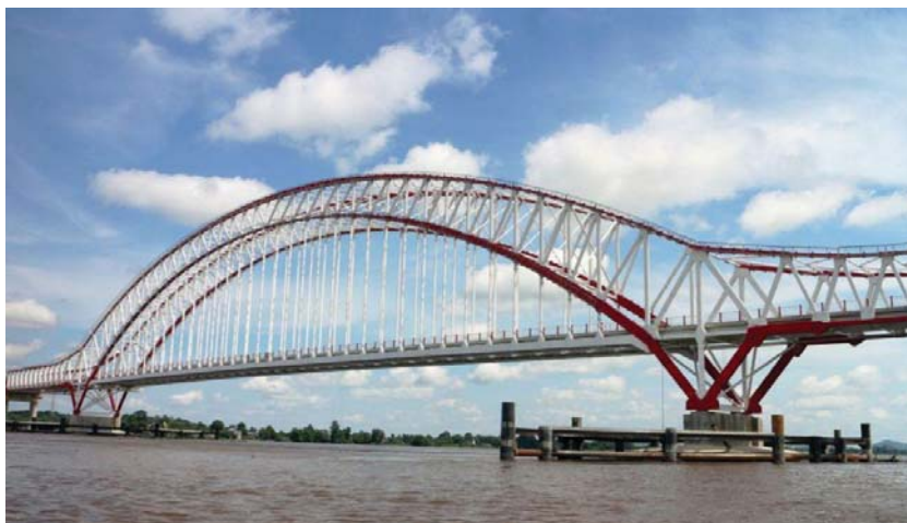
Gambar 1. 2 Jembatan Tayan tampak dari samping
