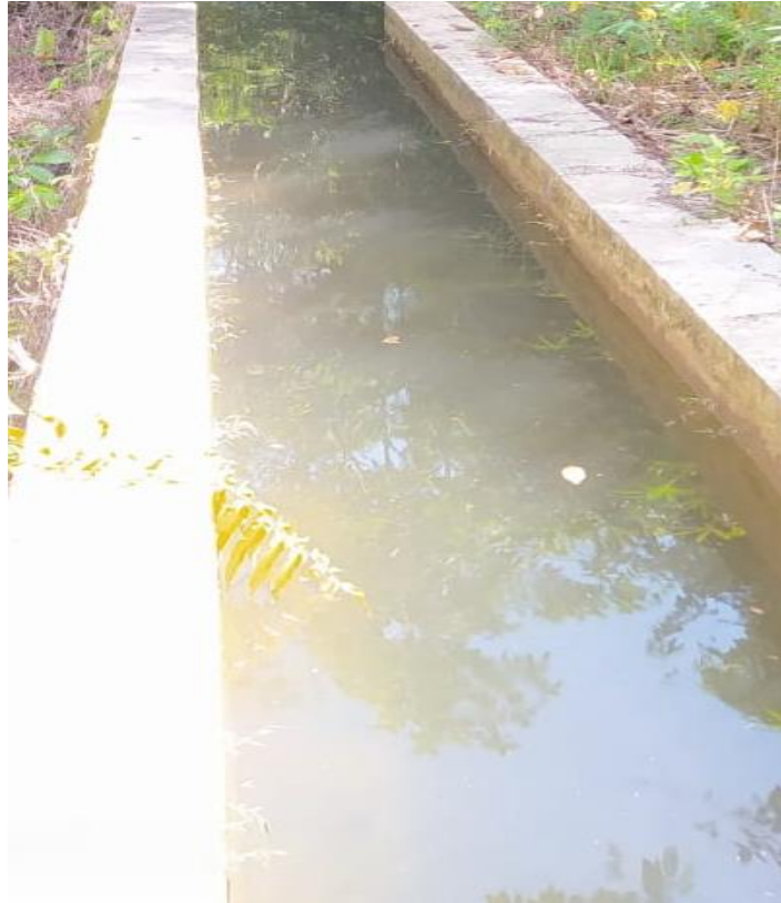
Gambar 2.3 Bangunan Saluran Pembawa ( Headrace )
