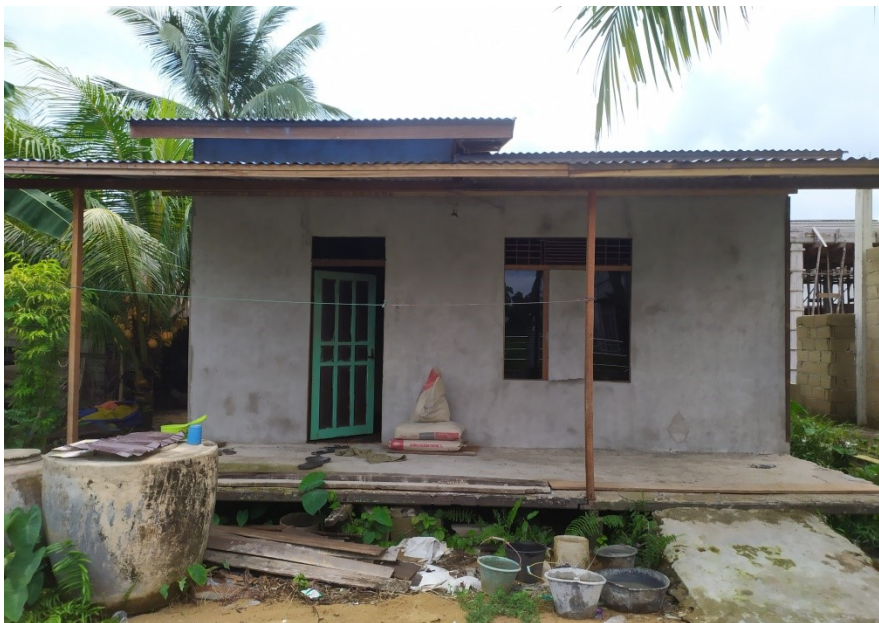
Gambar Rumah warga yang sudah di bedah
