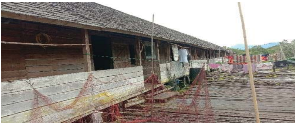
Gambar3 Penampakan depan rumah panjang Dusun Ngaung Keruh
