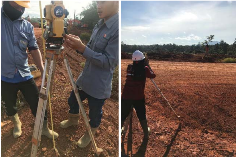
Gambar 3. 1. Pengambilan Data Koordinat Dan Elevasi Geometri Jalan
