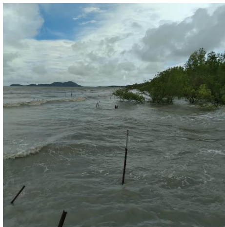
Gambar 1. 1 Kondisi fisik Pantai Desa Mendalok Tahun 2021 Sumber : Dokumentasi 2022
