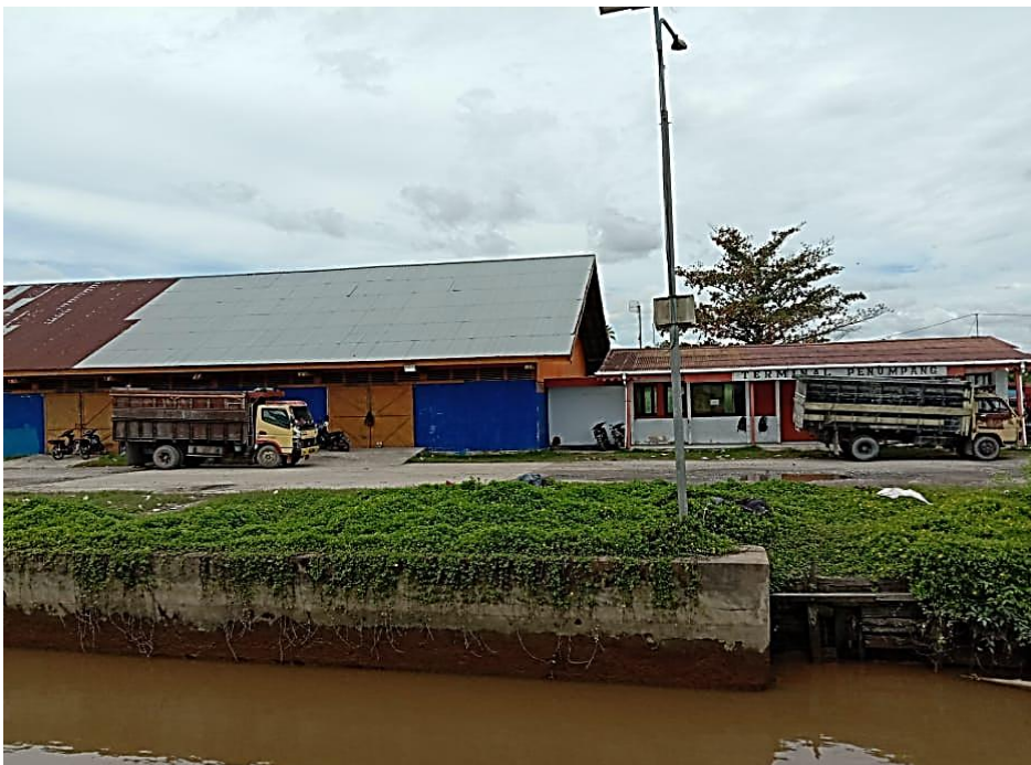
Gambar 1.3 Kondisi Terminal Penumpang dan Gudang Pelabuhan
