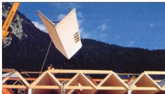
Gambar 2.22 Penginstalasian atap folded dengan material kayu Sumber: DBZ Architecture Bautechnik Bauprodukte, 2000
