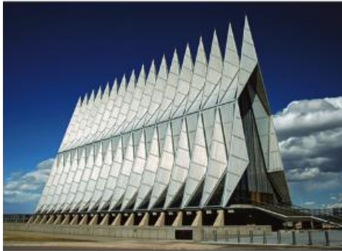
Gambar 2.23 Bangunan folded menggunakan material baja Sumber: Skyscrapercity, 2015
