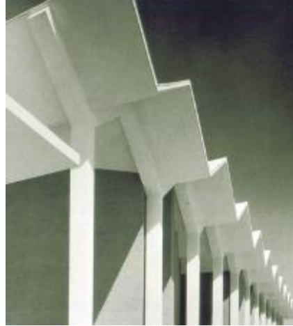
Gambar 2.21 Struktur atap folded dengan material beton bertulang Sumber: Wilby, 1998
