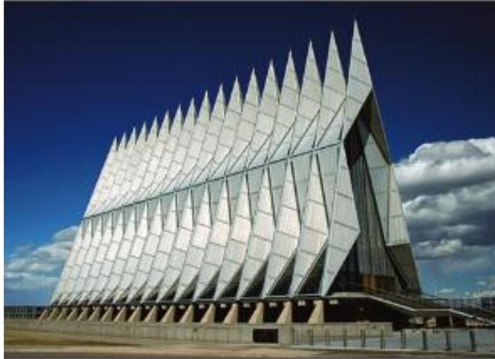
**Gambar 2.23** Bangunan *folded* menggunakan material baja
