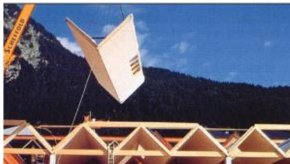
**Gambar 2.22** Penginstalasian atap *folded* dengan material kayu
