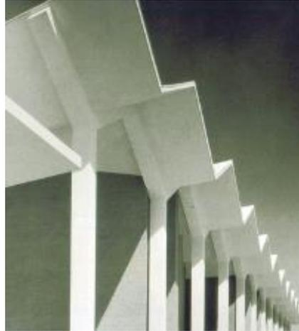
**Gambar 2.21** Struktur atap *folded* dengan material beton bertulang
