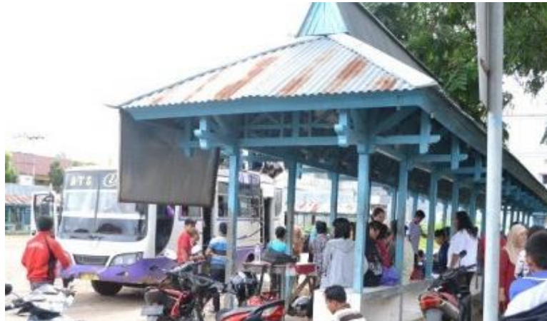
Gambar 1. 2 Kondisi Fasilitas Terminal Lawang Kuari Sumber: https://thetanjungpuratimes.com (diakses tanggal 05 Desember 2021)
