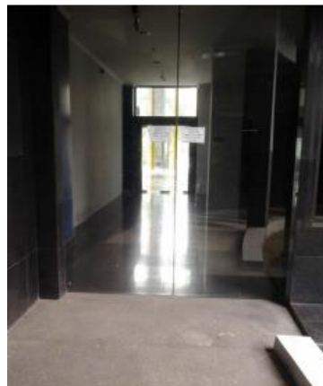
Gambar 2. 38. Pintu Geser pada Gedung Utama FEB UB Sumber : Jefri, 2016
