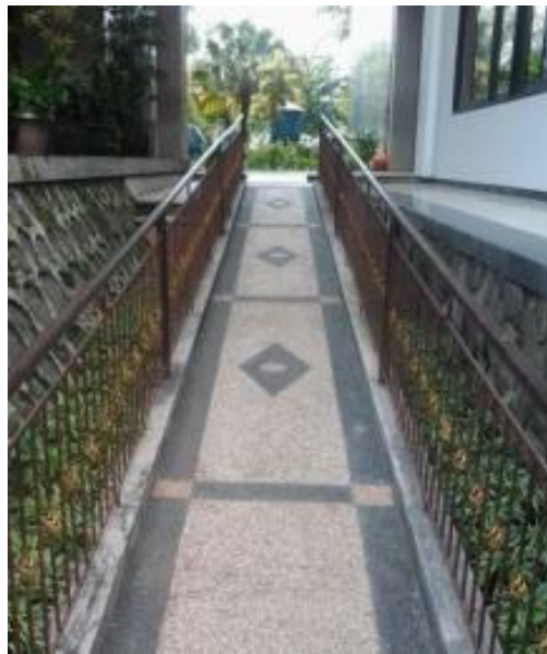
Gambar 2. 39. Ramp di FIA UB Sumber : Jefri, 2016
