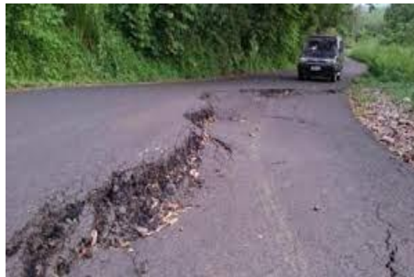
Gambar 2. 21 Pinggiran Jalan Turun Vertikal
