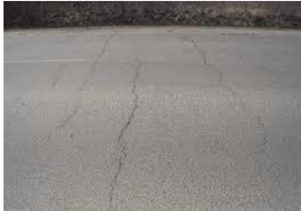
Gambar 2. 23 Retak Memanjang/Melintang
