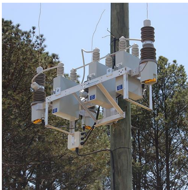
Gambar 2.7. Kapasitor Bank Pada Tiang Distribusi (Sumber: www.eaton.com )
