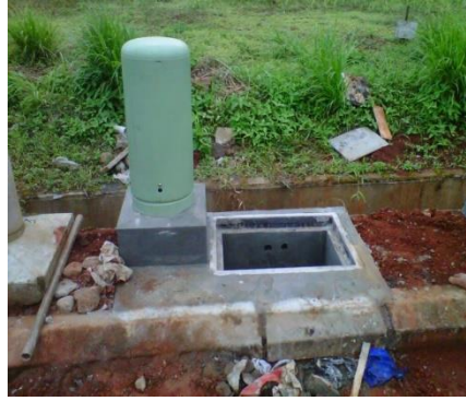
Gambar 2.11 ODP Pedestal
