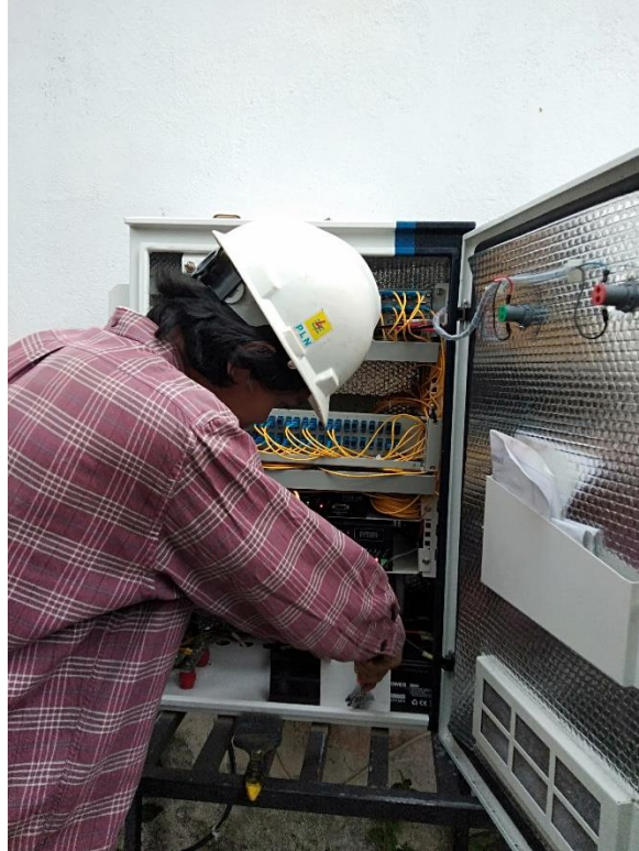
Gambar D.3 Perbaiki Patchcord Di POP Tabrani Ahmad
