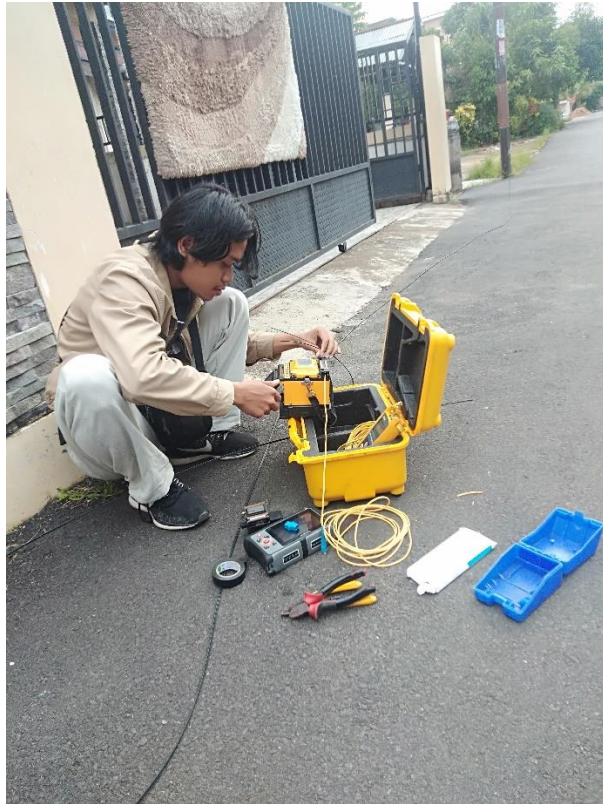
Gambar D.5 Join Ulang Kabel DW Di Jalan Tebu
