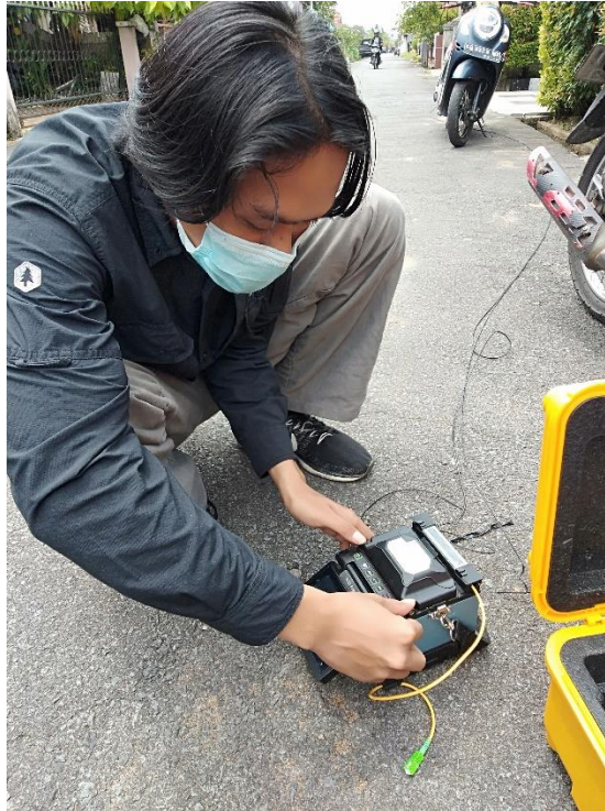
Gambar D.1 Join Ulang Patchcord di ODP Purnama
