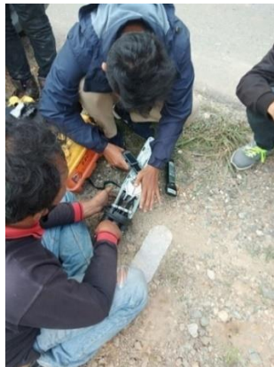
Gambar 4.8 Cek Core yang Putus di Joint Box (Samarinda)
