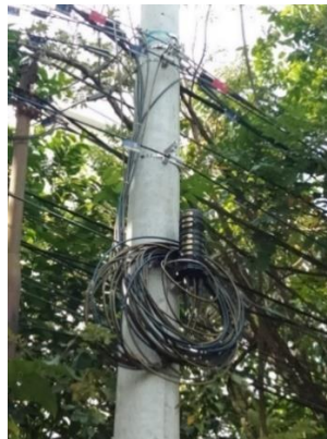
Gambar 4.7 Joint Box (Samarinda)
