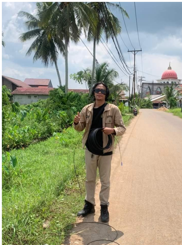
Gambar D.4 Tarik Ulang Kabel DW Di Kota Baru Ujung
