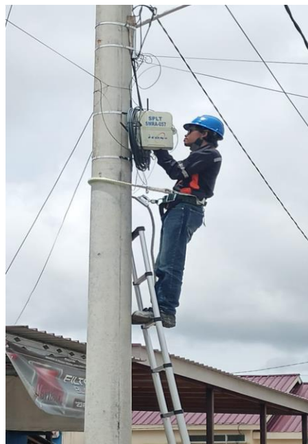
Gambar 4.10 Pengecekan Jalur Di ODP (Samarinda)
