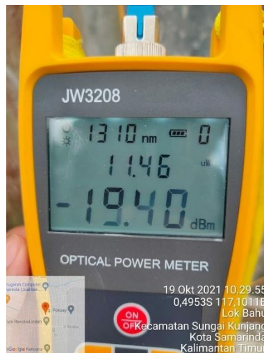
Gambar B.4 Deteksi Redaman Kabel Yang LOSS Di ODP Samarinda
