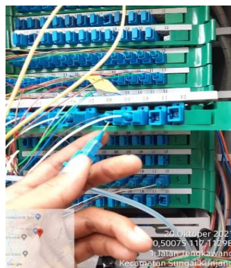
Gambar 4.5 Penggantian Konektor port 11 di FDT (Samarinda)
