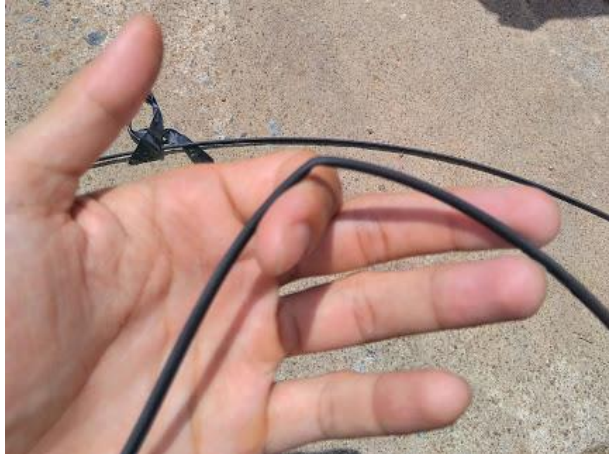
Gambar 4.15 Bending Pada Kabel Serat Optik
