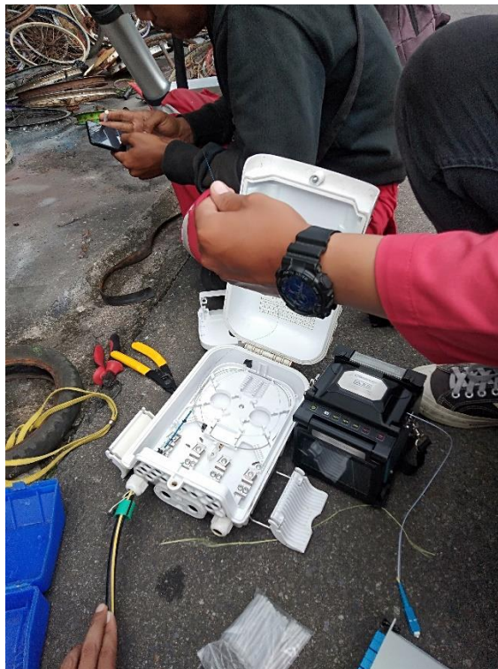
Gambar D.2 Perbaiki Inputan ODP Jeruju
