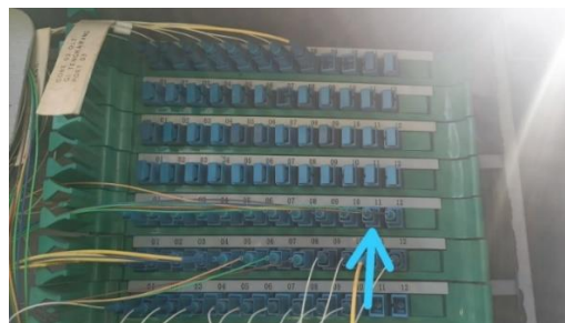
Gambar 4.6 Penggantian Konektor port 11 di FDT (Samarinda)
