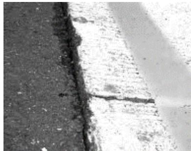
**Gambar 2.12** Retak sambungan bahu dan perkerasan
